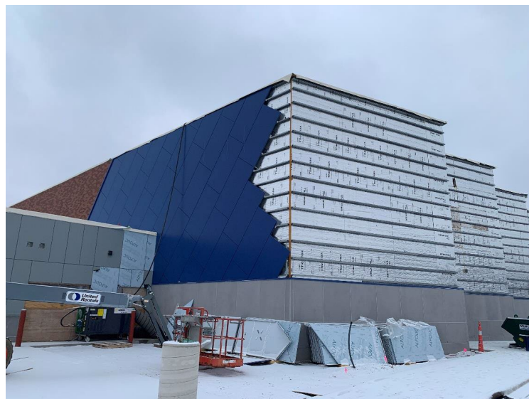
Avance en los paneles de pared en el área sureste de la escuela.
