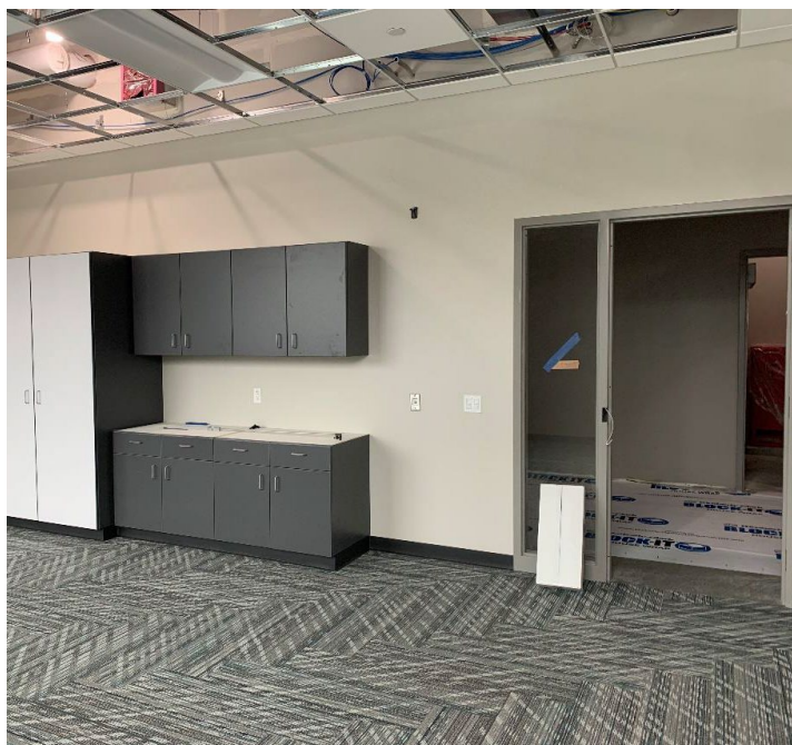
Se alfombraron las oficinas del segundo piso y está en progreso la instalación de las estanterías.
